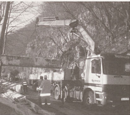
Postavljanje zaščitne betonske ograje na cesto Pod stenami. (Foto: Lucijan Trošt)
