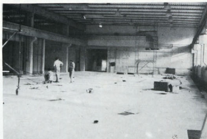
Vzdrževalci bodo končno dobili nove prostore za delo. Na sliki notranjost hale A v gradnji
