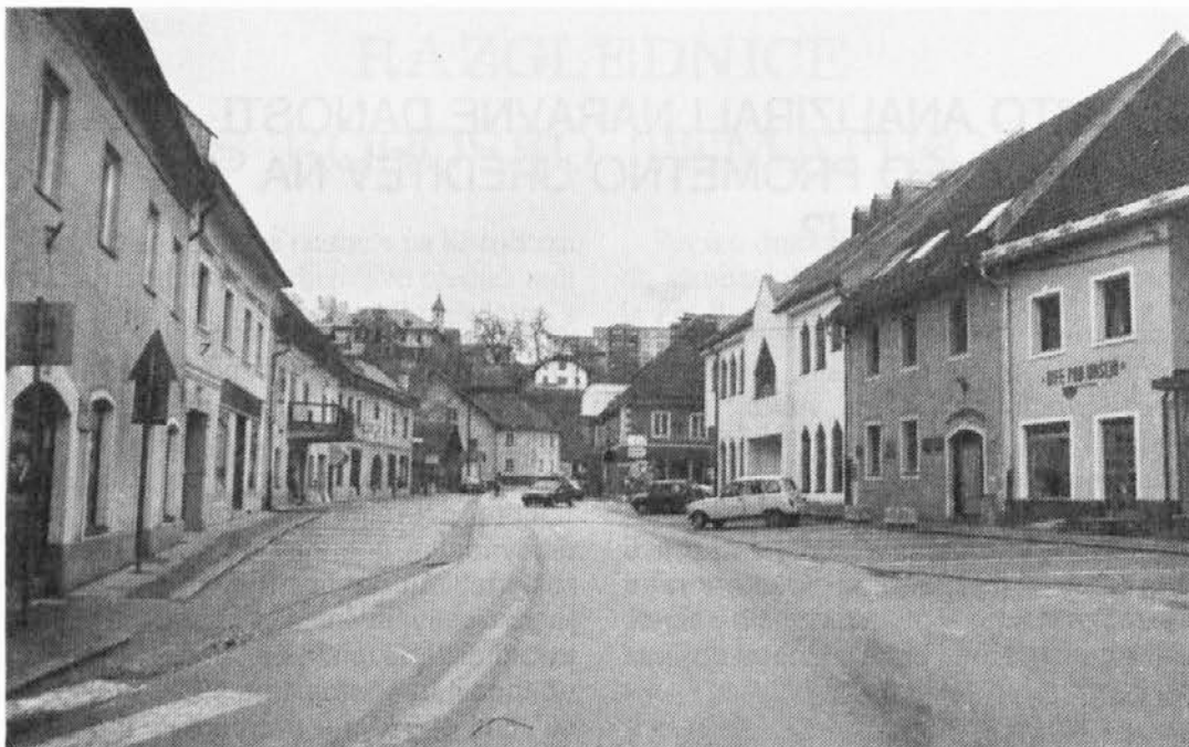
Ravenski trg. V ozadju grad Javornik, ki čaka na dokončno obnovitev
