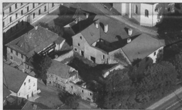
Pogled na Valvasorjev kompleks v Krškem
