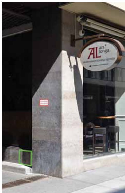
Mesto plošče asilinsko-numulitnega apnenca pri izhodu pasáže Nebotičnika na Cankarjevo ulico. Foto: Matevž Novak.
