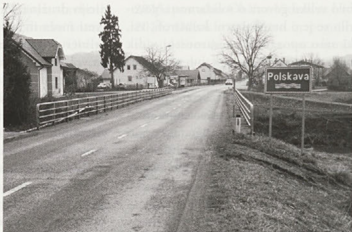
Na tem mestu, na vzporedni cesti, bo izgrajen novi most.
