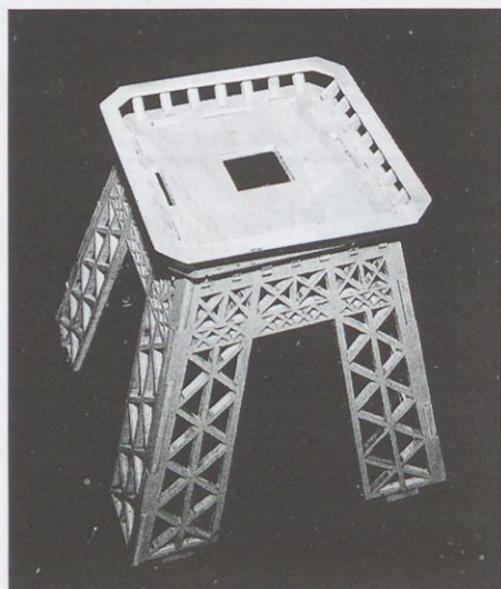
Slika 3. Oporniki druge ploščadi so hkrati tudi nosilci ograje.
