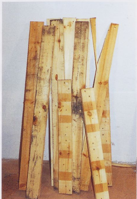
Slika 4. S težjim kladivom razstavite paleto in iz dobljenih letev s kleščami izvlecite vse žebelje. Morebitne ostanke peska odstranite z žično krtačo.
