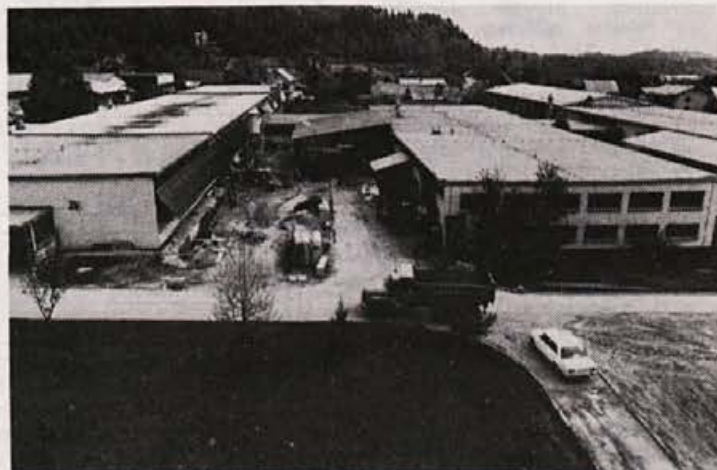
Prestavitev nadstrešja in popravilo na dvorišču pred kovinskim obratom
