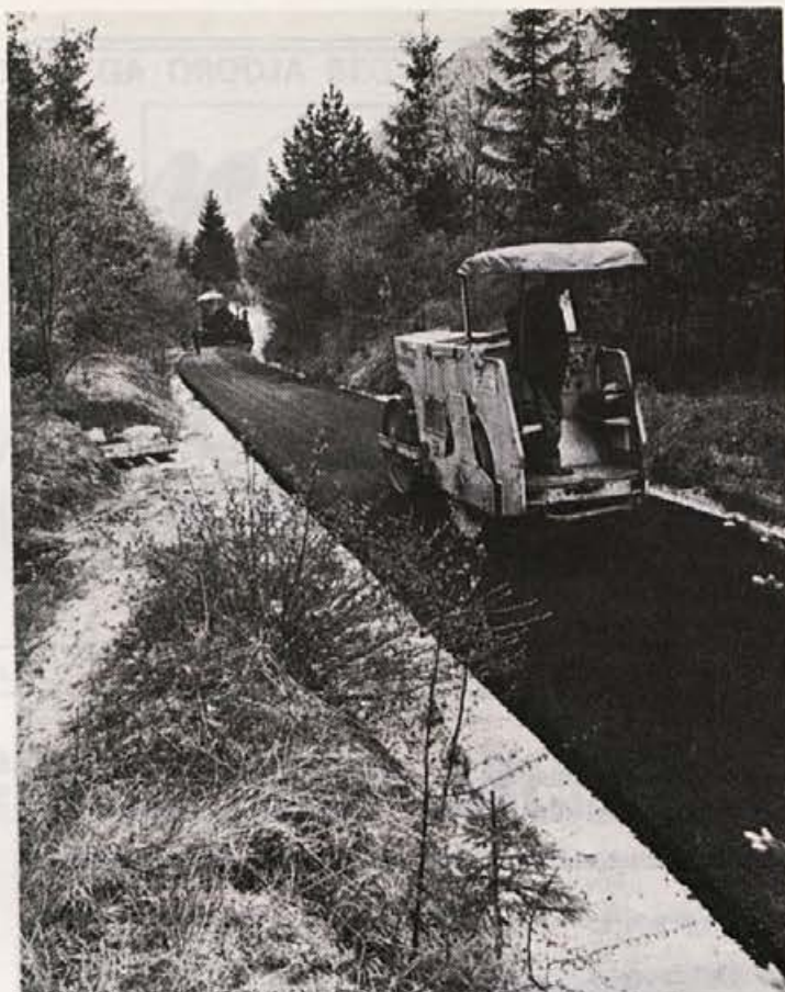
Tako so potekala dela asfaltiranja ceste v Drago
