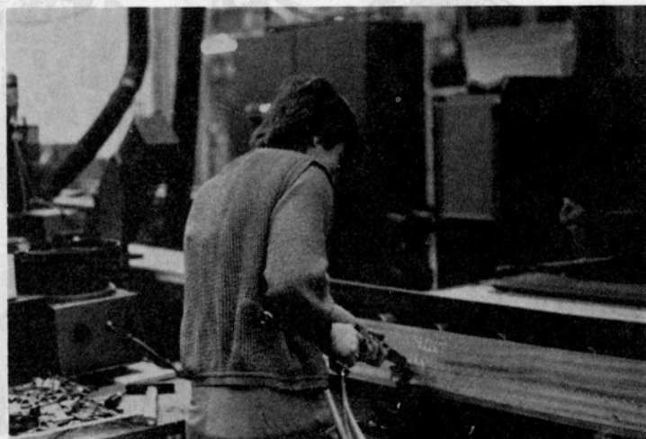
TO Rečica Montaža prijemnika na podobjih
