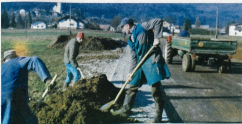
Številni krajani Krke, več kot 40 jih je prišlo, s traktorji, krampi in lopatami, in uredili so zemljišče ob obnovljeni cesti oziroma pločnikih. -Več na strani 7!
