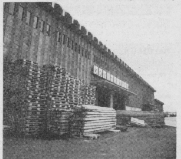
Novo večnamensko skladišče na Hudinji meri samo s pokritimi površinami 20 tisoč m 2 , k temu pa je treba prišteti tudi zunanje površine za »grobe« gradbene materiale.
