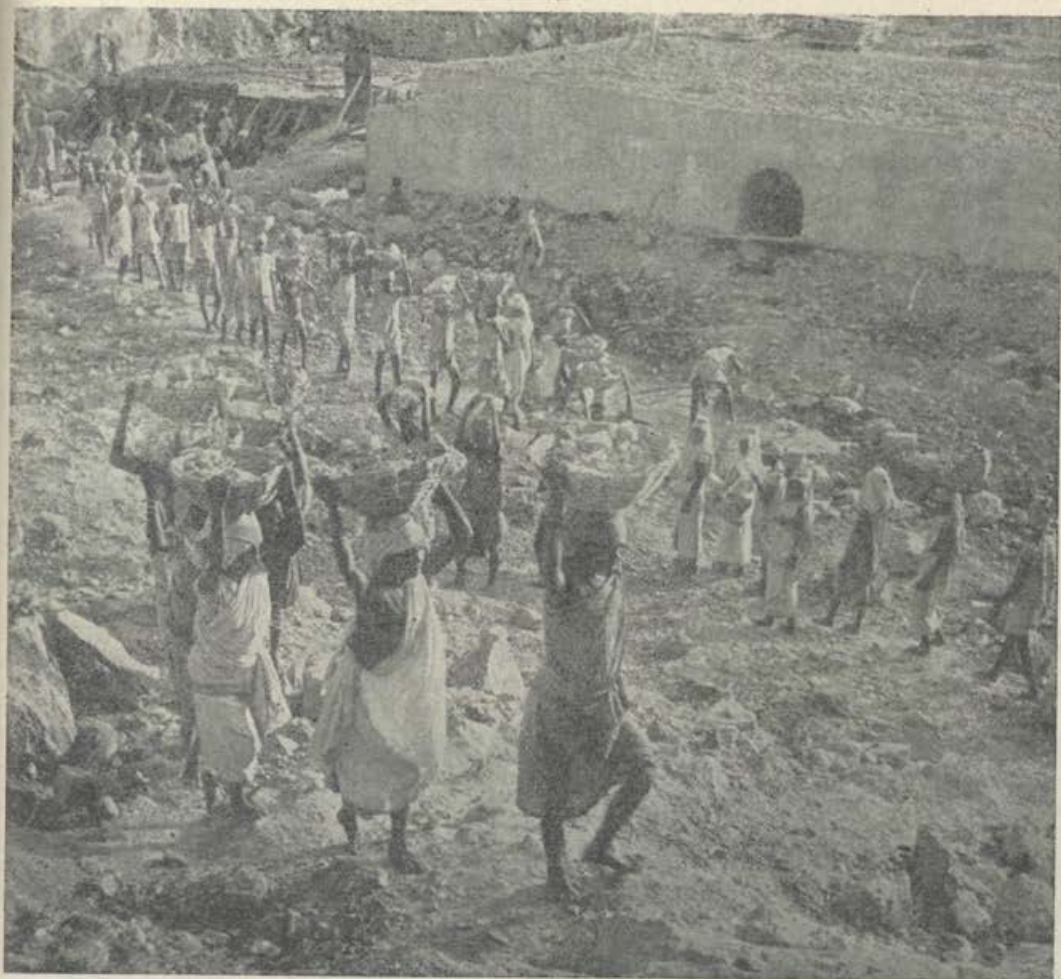
V mnogih deželah opravljajo težaška dela še brez strojev. Koliko delovne sile in naporenega dela — a majhen učinek. Slika kaže delo pri nasipu »Damodar Valley Project« v Indiji.
