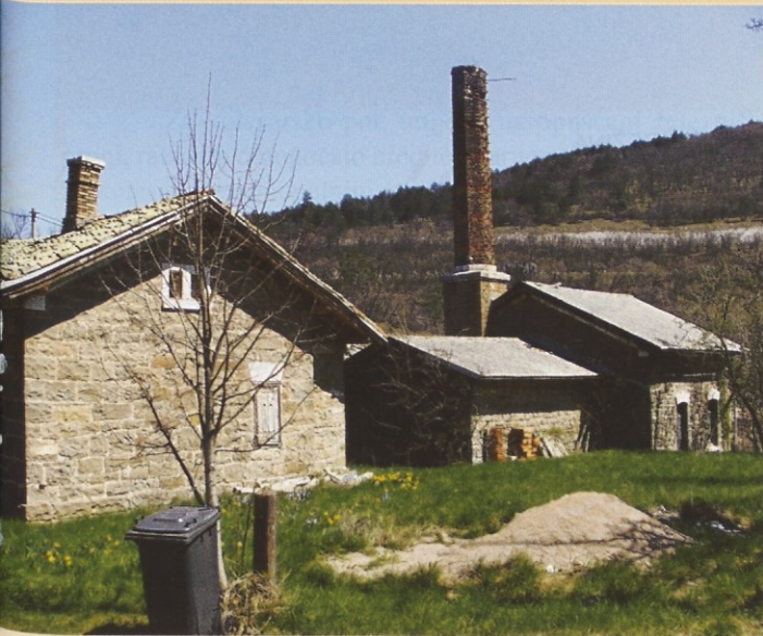
Objekt črpalne postaje v Klancu pri Kozini
