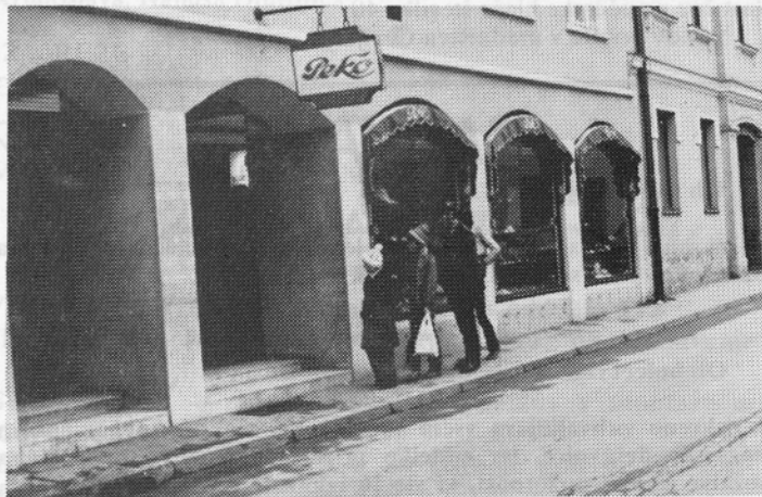
Poslovalnica Krško je po adaptaciji pridobila prostore v prvem nadstropju, s tem pa tudi dodatni program.
