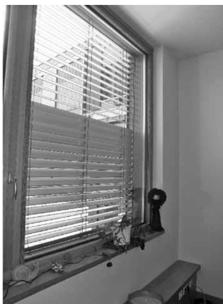
Slika 3: Nastavljive žaluzije – v zgornjem in spodnjem delu so lamele odprte za odboj svetlobe v strop in od tam v globino prostora, v srednjem delu zaprte za zaščito pred pregrevanjem
