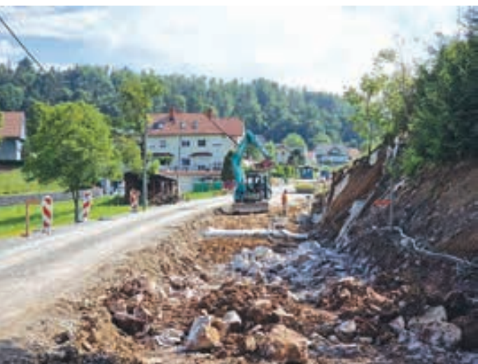
Zemeljska dela v Ligojni
