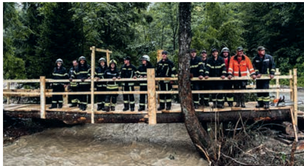
S skupnimi močmi do novega začasnega mosta prek deroče vode.
