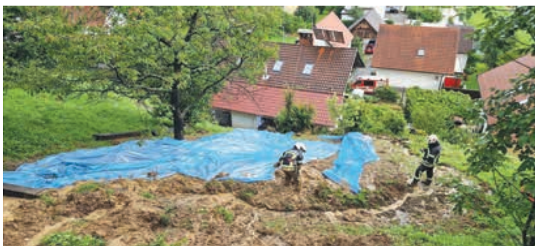
Večji zemeljski plaz na Drenovem Griču nad bivanjskim objektom.
