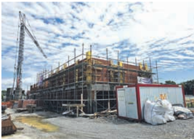
Sicer ne diši po asfaltu, ampak po malti – gradnja garderobnega objekta v športnem parku lepo napreduje. Razgled s terase zaenkrat uživajo samo delavci, drugo leto naj bi ga tudi že športniki in navijači.
