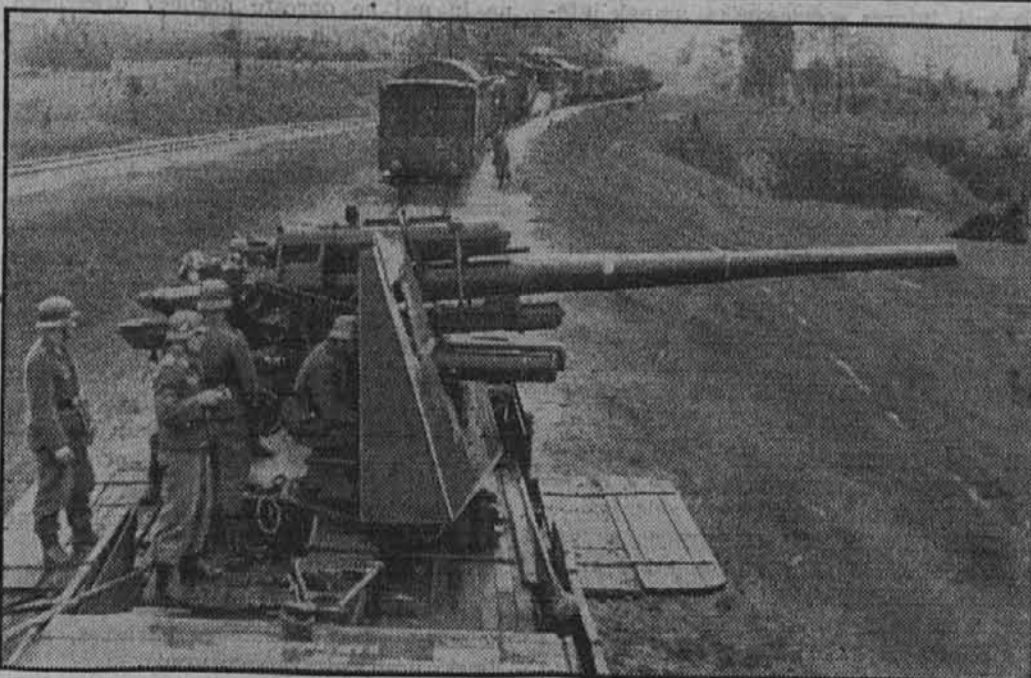
Zavarovanje proga na delu Spotoma, da zavaruje progo za nove pošiljke.
