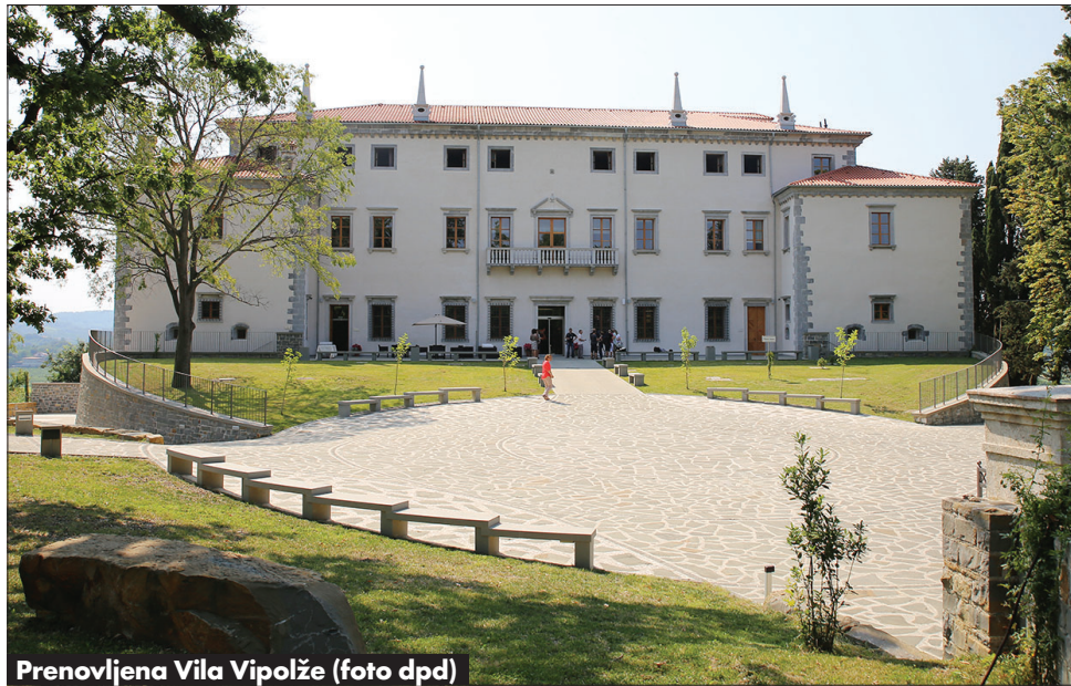
Prenovljena Vila Vipolže (foto dpd)
