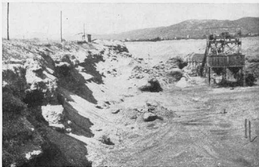
Fot. 2. Mehanizirana gramoznica ob Vrtojbi. Prod ne izkoriščajo v ježi terase, ker je tam sprijet, temveč okoli 150 m vstran, kjer je zlepljenost rahla
