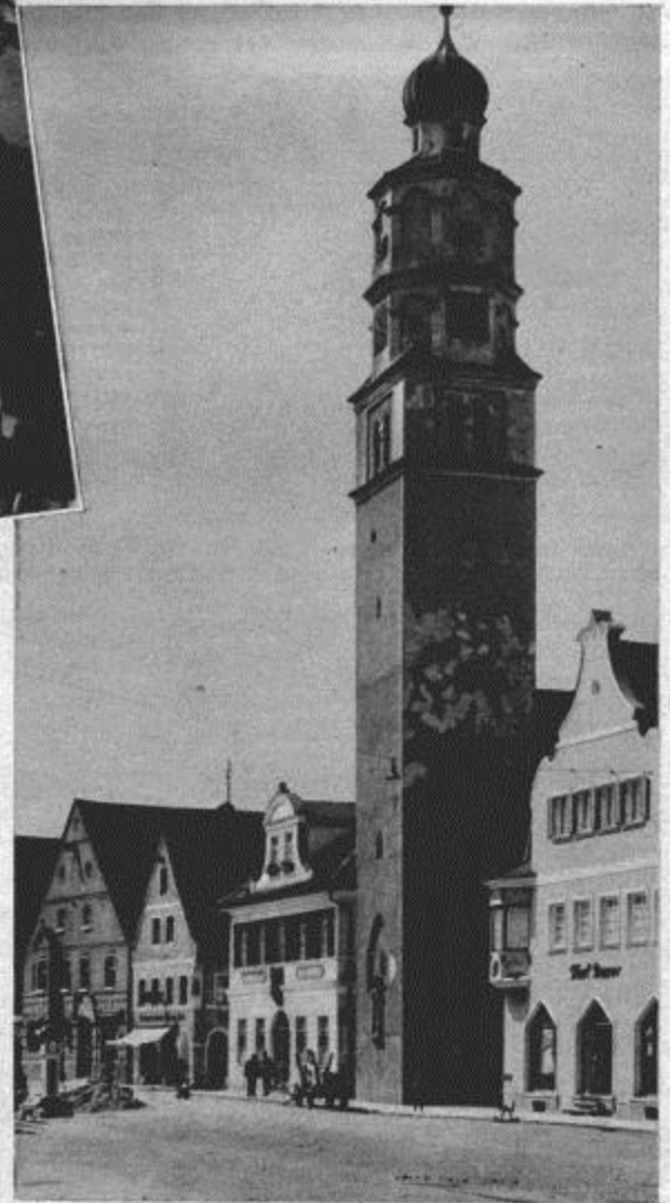
Auch Schrobenhausen in Oberbayern begeht im Sommer festlich sein 1200-jähriges Bestehen. Das alte Städtchen hat sich bis auf den heutigen Tag seine Befestigungsanlagen erhalten. — Die Hauptstraße mit dem Turm der Frauenkirche
