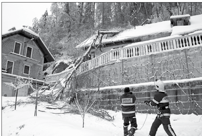
Gasilci PGD Grušovlje pri odstranjevanju drevesa s stanovanjskega objekta (Foto: MŠ)
