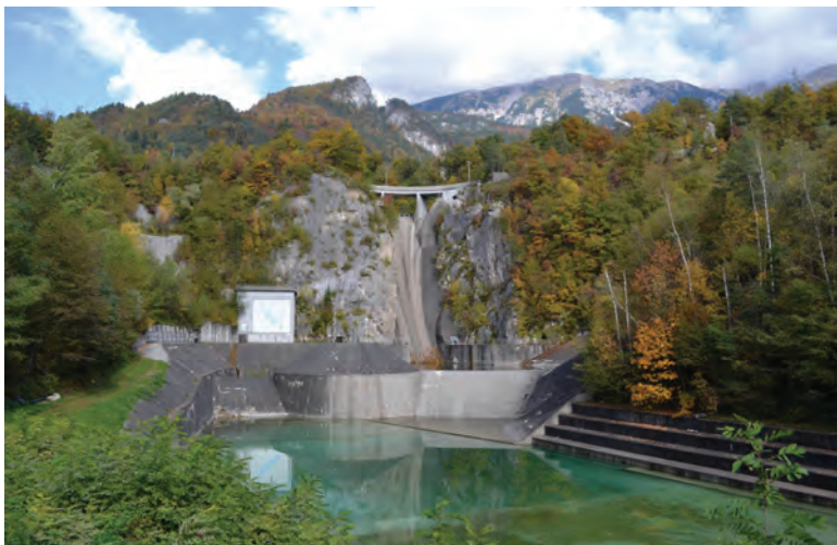
Slika 3: Pogled na pregrado Moste z dolvodne strani (foto: P. Žvanut).
