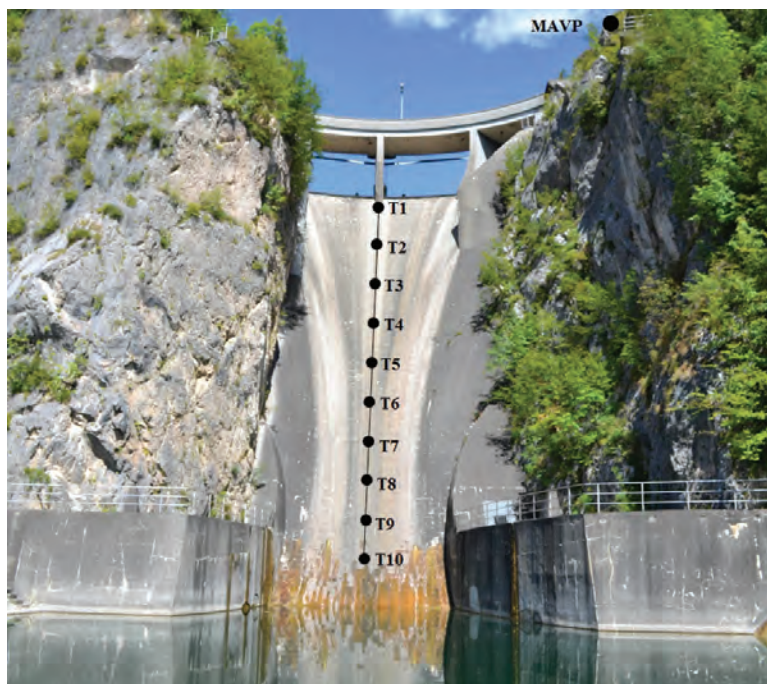
Slika 6: Lokacija vremenske postaje (MAVP) in opazovalnih točk v osi dolvodne površine pregrade Moste.
