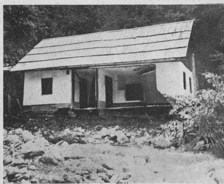
Hiša Šimna Vrhovnika na Koroški Beli, kateri je odtrgala voda velik del sprednje stene.
