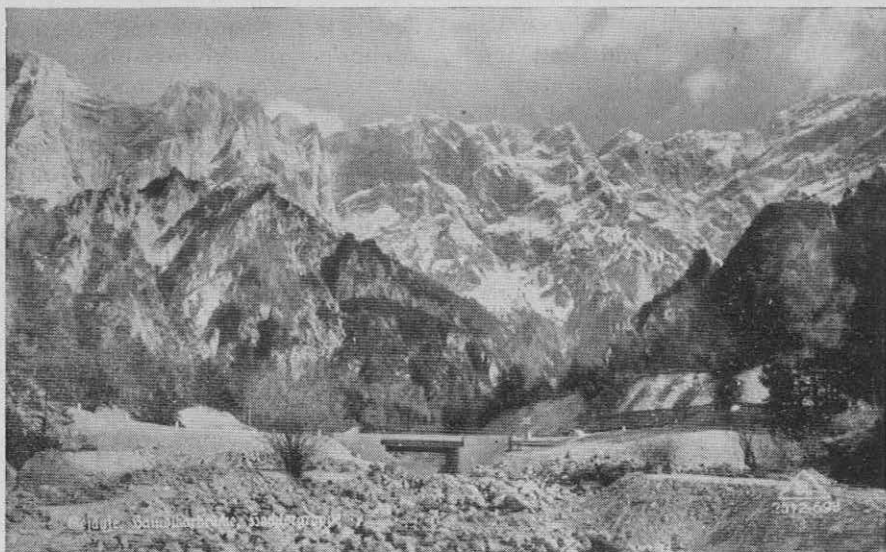
Gesäuse s Haindlkarskega mostu; skupina Hochtor.
