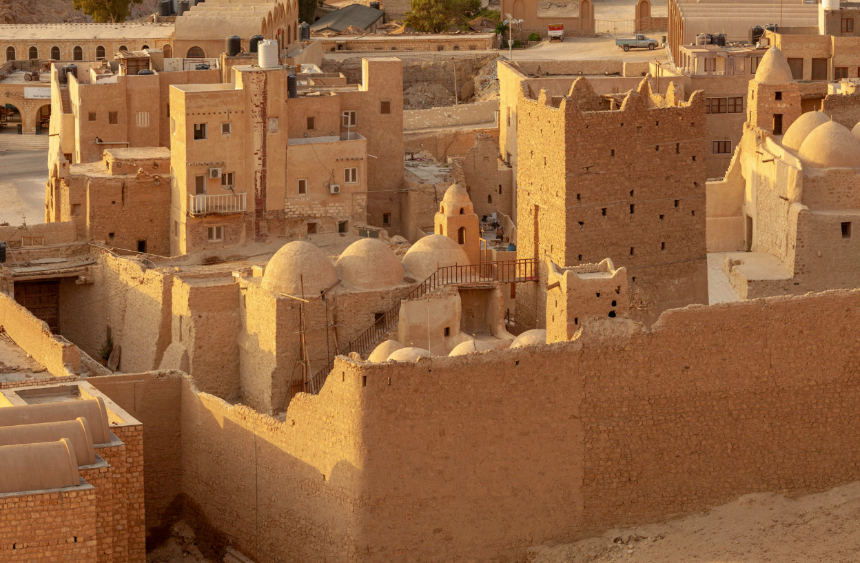
Slika 27: Pogled na obzidje in staro jedro samostana sv. Pavla, Vzhodna puščava
