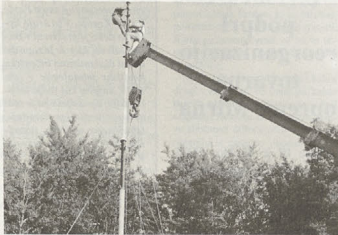
Mikroregulacijski sistem omogoča komunalcem pregled nad delovanjem in odkrivanje napak vodovodnega sistema Temenica. 20 metrski antenski stolp zgrajen ob vodohramu kapacitete 30 m 3 , na Vrhtrebnjem vzdržuje kvalitetne govorne in teletrijske zveze.
