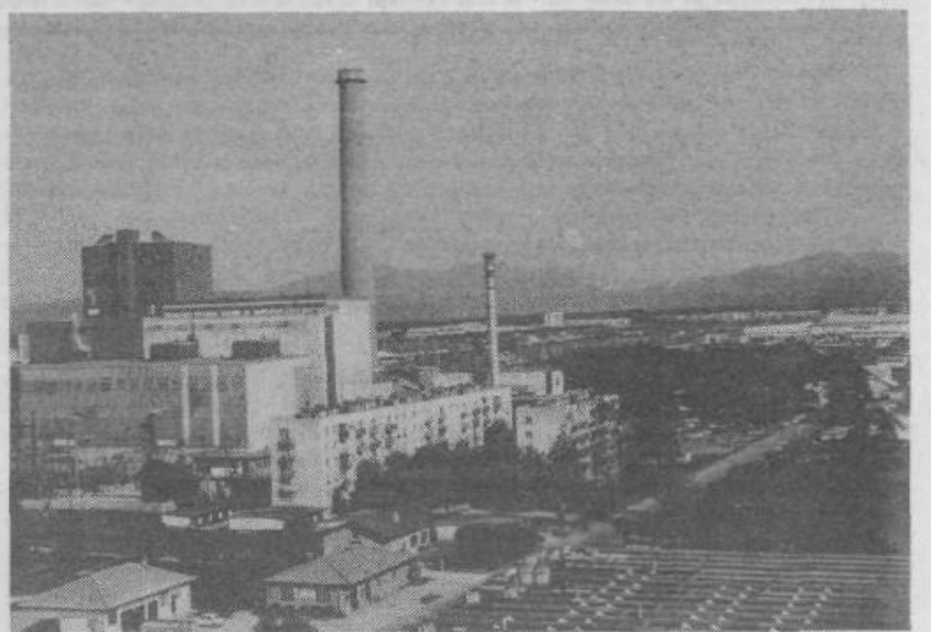
Toplarna in stanovanjski bloki v Toplarniški ulici. (Foto: D. G.)
