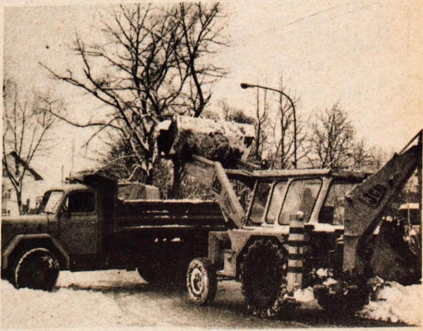
Kranjsko komunalno podjetje se je lotilo strojnega čiščenja pločnikov, ki se je izkazalo učinkovitejše od ročnega. Tovornjaki odvažajo sneg v strugo Kokre. Žal neprimerno postavljeni drogovi javne razsvetljave na robovih pločnikov ovirajo nemoteno delo strojev. (jk) – Foto: F. Perdan
