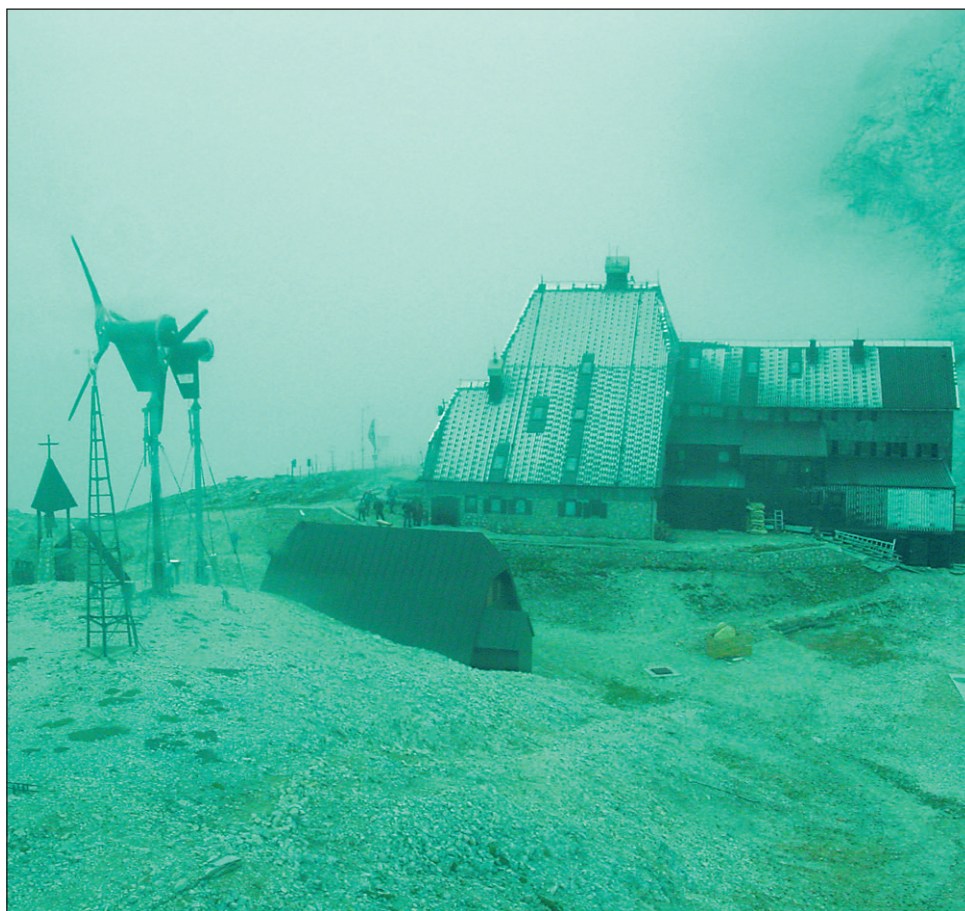
Triglavski dom na Kredarici obišče vsako leto več kot osemdeset tisoč planincev, dom pa dobiva električno energijo s pomočjo sončnih celic in dveh vetrnih elektrarn.
