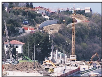
Gradnja predora se je (spet) ustavila.
