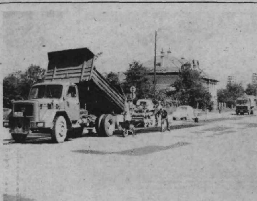
Zima, promet in leta tudi Titovi cesti niso prizanesli. Vzcvetela je, tako kot številne druge naše ceste, želja po niso vzcveteli tudi žiro račun naših cestarjev. Kljub temu so sredi maja pričeli obnavljati Titovo cesto, zakrpali so največje luknje in tako je cestna površina prav pisana: kocke, vmes malo starega asfalta, pa spet nove asfaltna krpe. Do prihodnje zime bo že vzdrževali. Hkrati so zarisali talne oznake.
