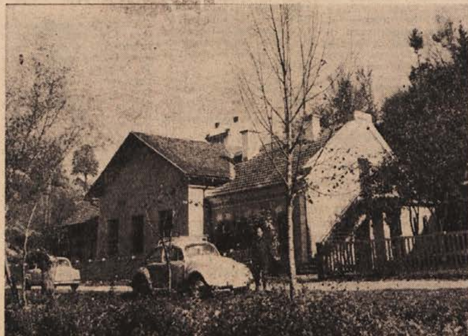
Stavba črpalnice novomeškega vodovoda v Stopičah. Na sliki v naslovu naprave črpalnice, ki je bila obnovljena l. 1945. (Foto: M. Jakopec)
