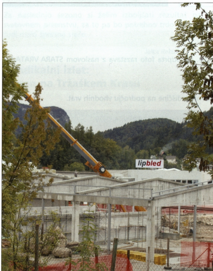
Gradnja novega trgovskega centra na Rečici poteka po planu
