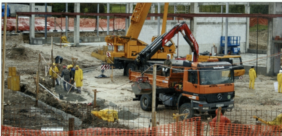
Gradnja nove trgovine
