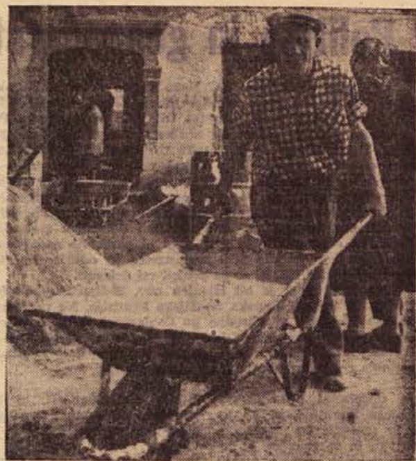
Člani komisije »Dane« na Mirni potekajo zadnja dela pri ureditvi moderne restavracije s tujskimi sobami. Upamo, da bo stavba kmalu služila svojemu namenu.
