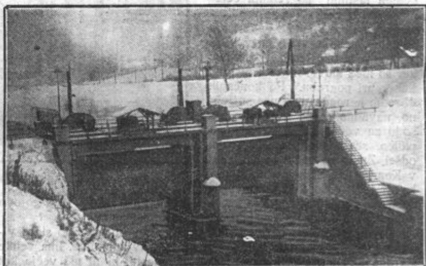
Velike zatvornice ob Ljubljani , ki so bile pred leti postavljene za odvajanje vode in osuševanje barja so pred kratkim odstranili, ker je voda sedaj že precej uravnana. V krajih kjer je bilo pred leti samo neprehodno močvirje, so sedaj lepe njive in travniki, katere bodo s časom še znatno razširili
