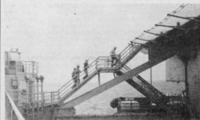
Sprehod s prednje (leve) noge na glavno palubo ploščadi od blizu. Sicer ima Zagreb 1 pet takšnih nog, vsaka pa meri v premeru od 8 do 10 m.
