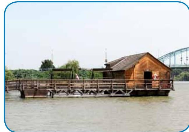
Rekonstrüérani mlin držine Gyurcsik v varaši Ráckeve - znautra njega vse normalno funkcionéra (ozajek je Árpádov maust)
