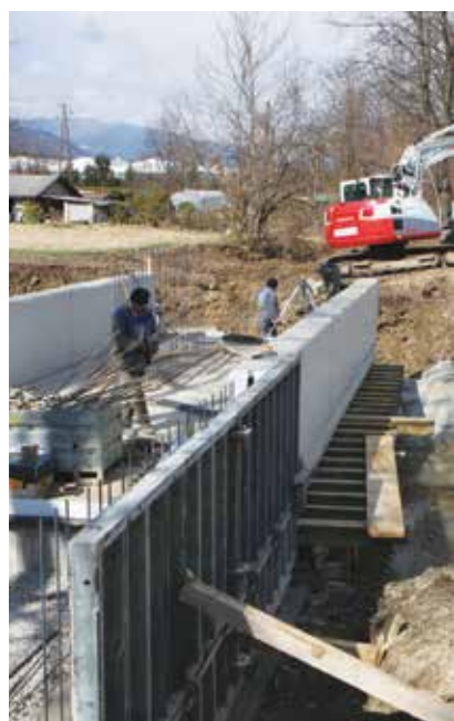
Med gradnjo novega akvadukta
