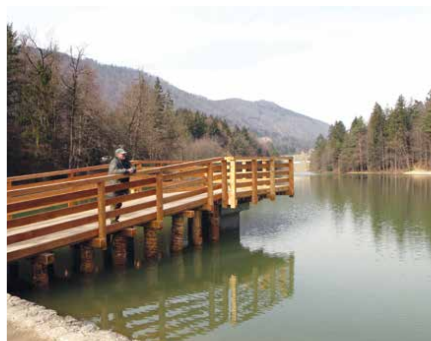
Dokončan razgledni pomol, ki je dolg 15 metrov in širok 3 metre
