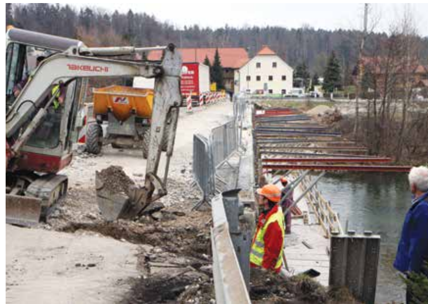
Obnova mostu v Letušu čez Savinjo
