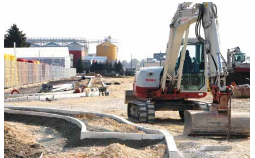
Nova cestna odseka bosta v teh dneh dobila tudi asfaltno prevleko.
