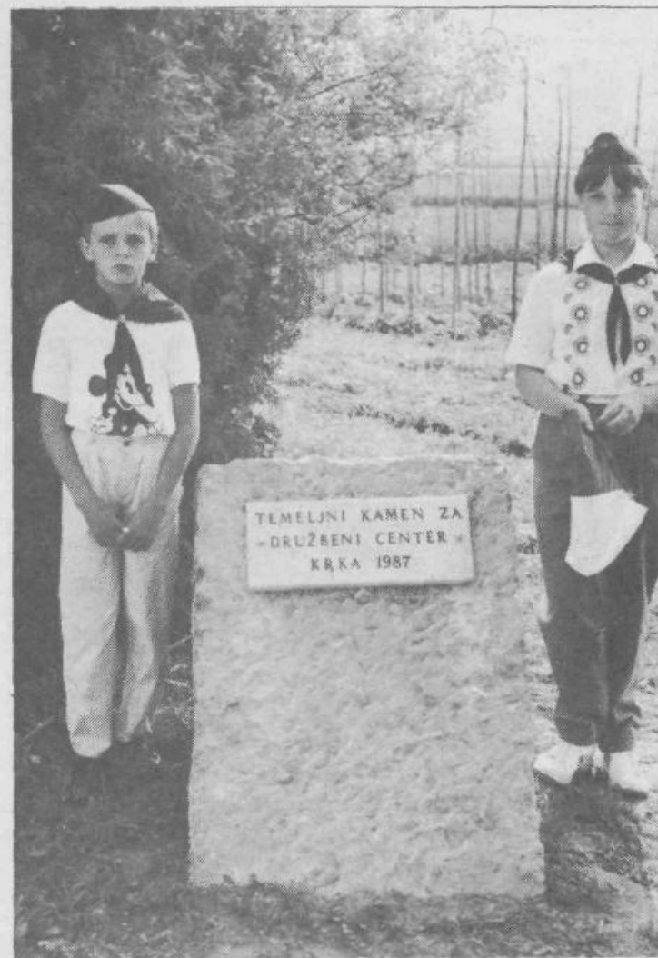
Postavitev temeljnega kamna za Družbeni center na Krki
