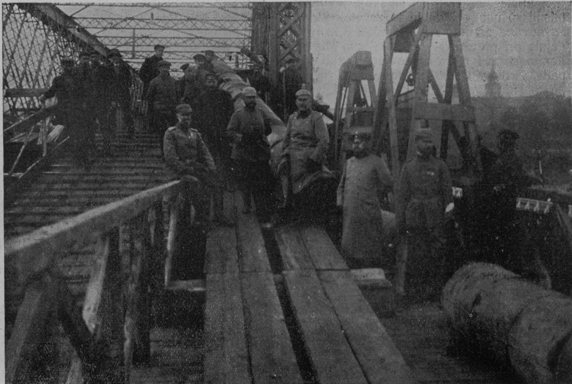
Nemški pionirji pri popravljanju mostu, ki so ga razrušili Rusi.
