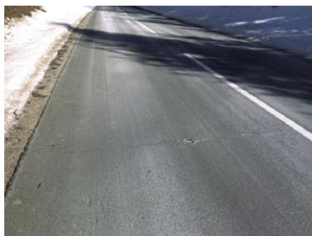
Slika 1a • Prečna razpoka (Babno Polje, februar 2012)
