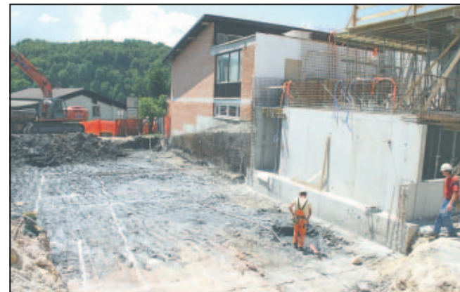
Priprave na gradnjo prizidka pri vrtcu šole.
