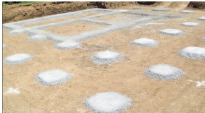
Postavljeni so že temelji poslovilnemu in servisnemu objektu.
