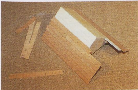
Slika 11. Prekrivanje strehe poteka s pomočjo pomožnih črt in od spodnjega roba proti slemenu.
