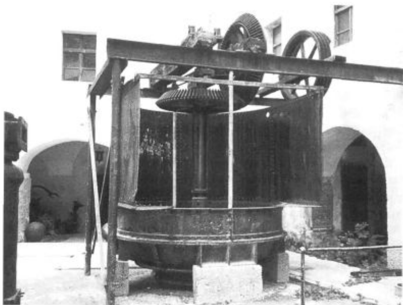
FRANCISOVA VODNA TURBINA IZ LETA 1893 NA GRAJSKEM DVORIŠČU PRED ZAČETKOM OBNOVE GRADU
