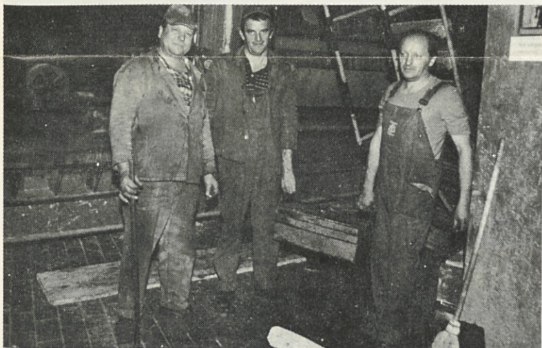
Med prvomajskimi prazniki so naši vzdrževalci na petem papirnem stroju opravili remont. Da je šlo delo hitreje od rok, so prišli na pomoč tudi količevski vzdrževalci
