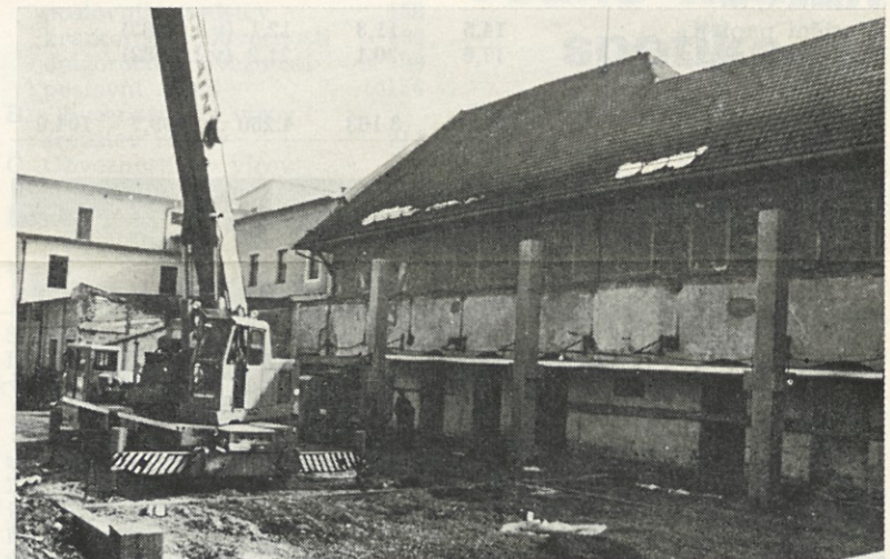
Iz tal so pognali cementni stebri za skelet nove tiskarne
