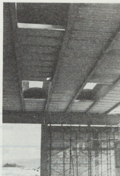
Že pokrita stropna konstrukcija na gradbišču nove tovarne stanje 30. 1. 1987
