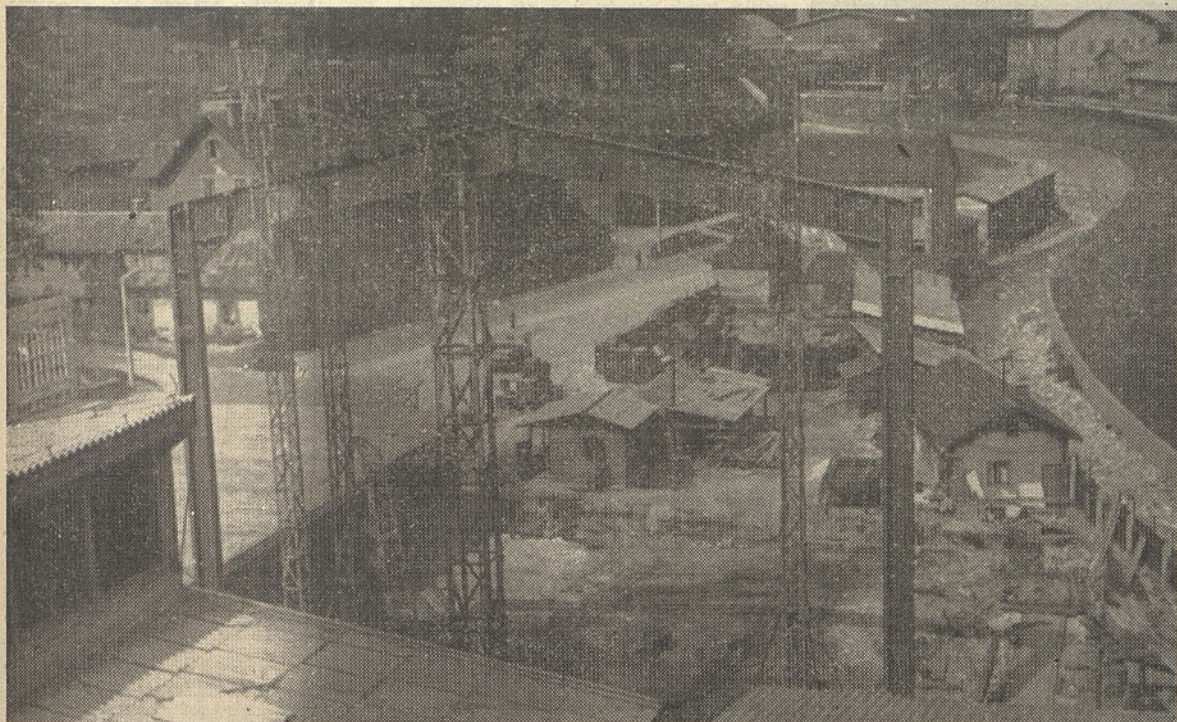
Postavitev prvega železnega opornika na novi hali avtomatične proizvodnje, s katero zaključujemo rekonstrukcijo steklarne Hrastnik.
