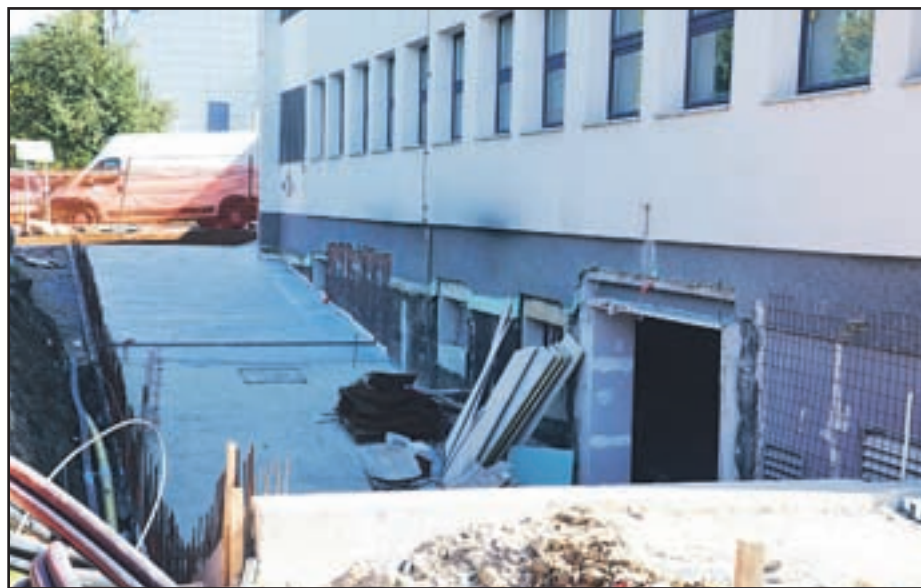
Gradbena dela se v teh dneh končujejo, potem pa bo treba malo dvorano, ki bo res povsem drugačna, še opremiti.
