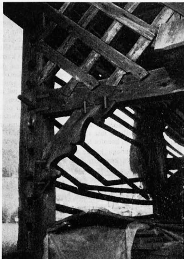
Detajl konstrukcije nosilnega in prečnega veznega tramu, podpore ročice in dela »brane« s sistemom tramičastega mreženja ponazarja posnetek kozolca z Dolenjega Boštanja, hiša št. 60 (1984)
