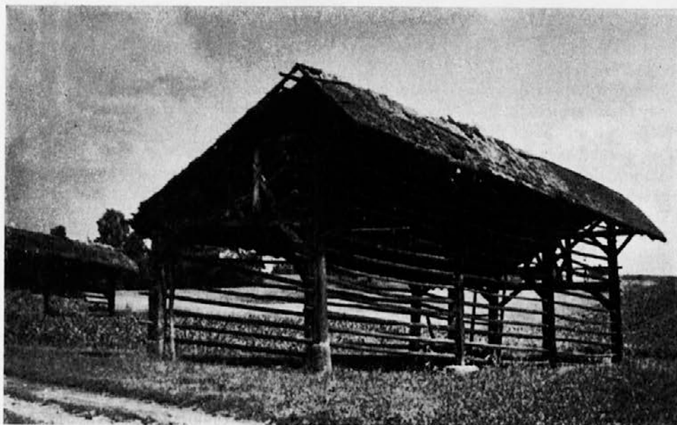
Tip dvojnega kozolca — kozolec na kozla z Blanškega polja. Nastal je sredi 19. stoletja, je pa eden redkih, ki so še prekriti s slamo (1984)
