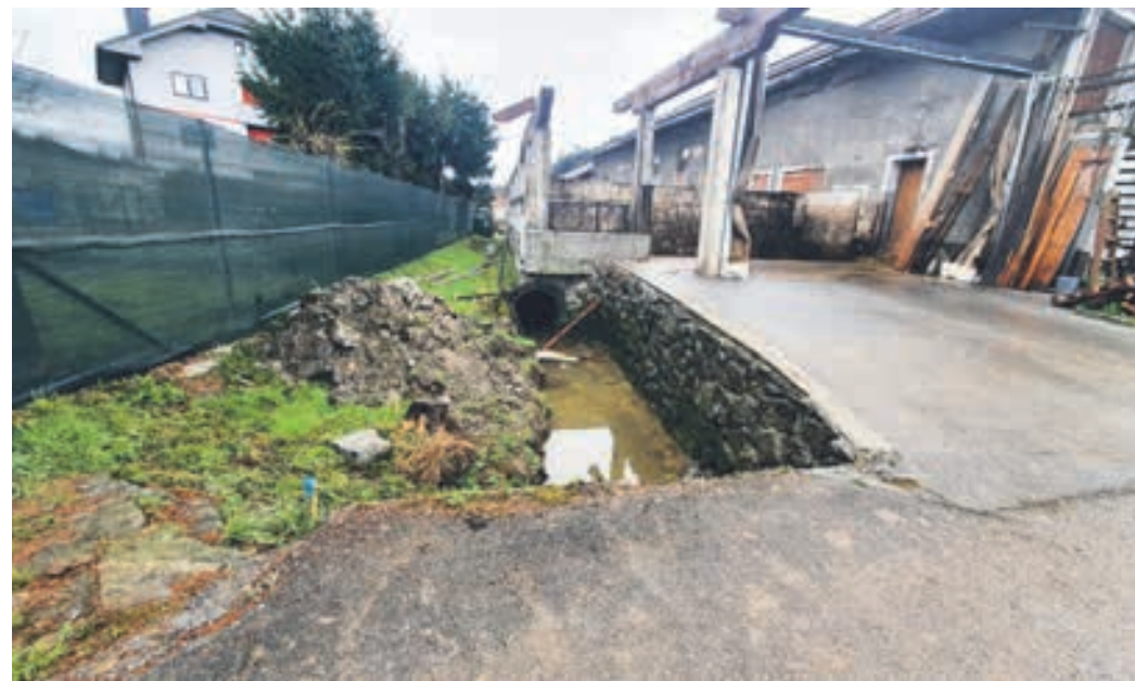
Na Vovcnah je bilo potrebno odstraniti cevi.
