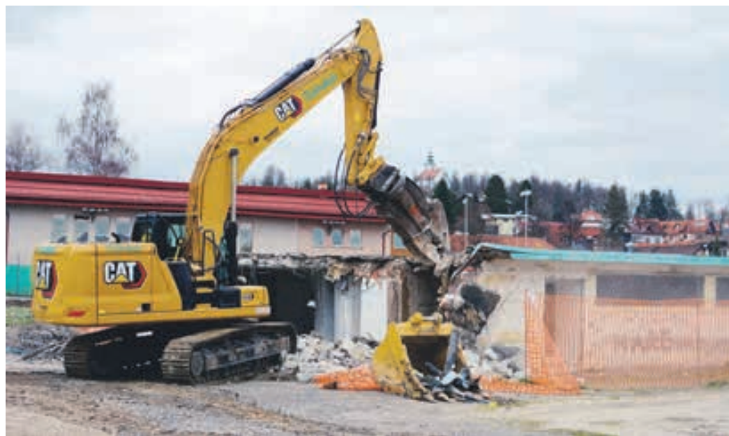
Začetek rušenja 69 let starega bazena
